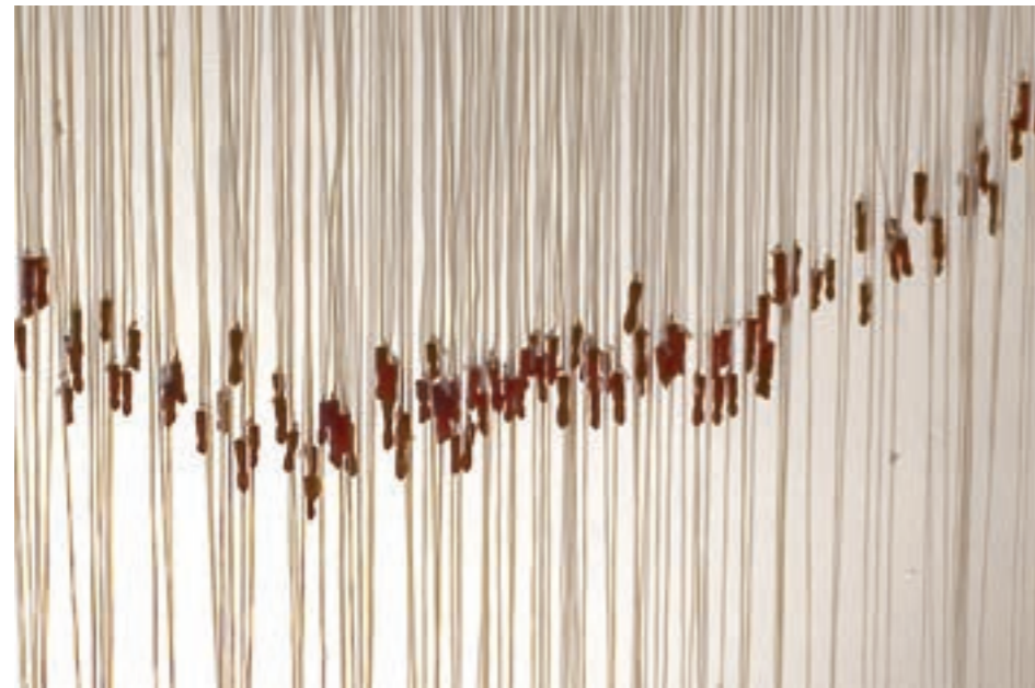
Detalhe - Instalação fios e mini-figas 2.0 x 3.0m
